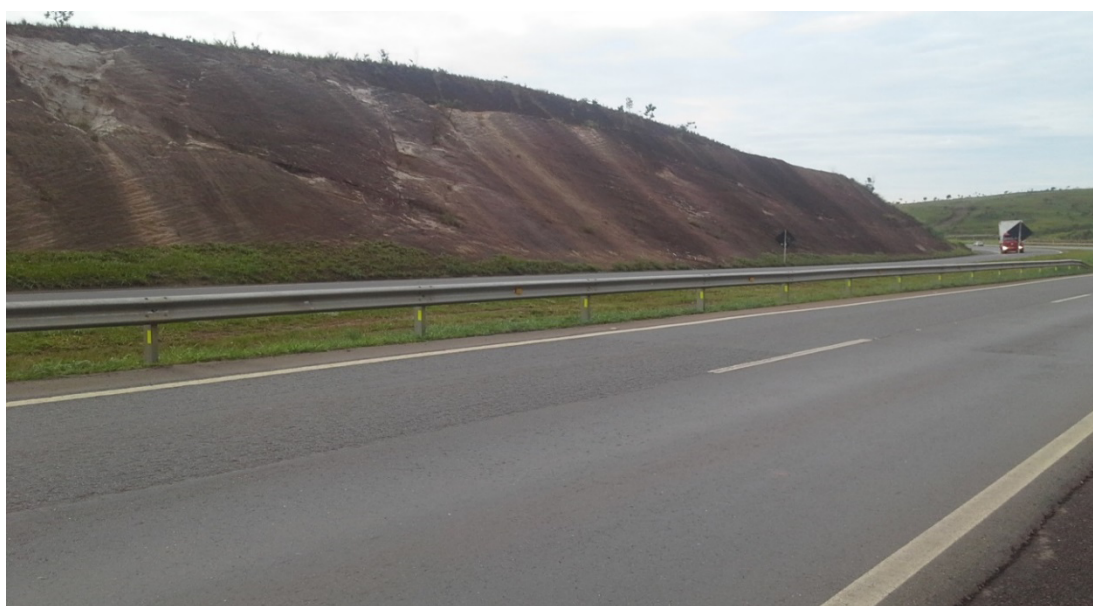
Figura R1 - 04: Corte lateral em trecho da BR-060 próximo a Engenho das Lajes demonstrando filitos e muscovita xistos em área de transição do Grupos Araxá/Canastra.
