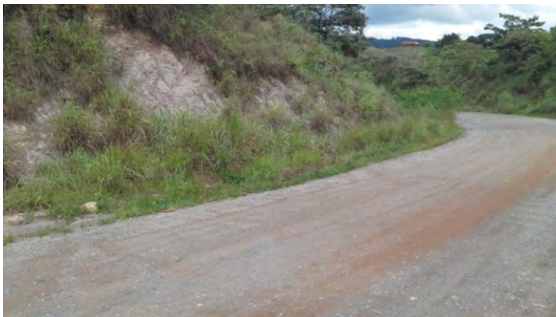
Figura R3 – 15: Calcixisto intemperizado em trecho da DF-205 próximo ao núcleo urbano da FERCAL.
