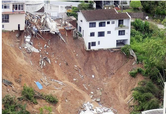
Fig. 03 - Deslizamentos de encostas ocorrido em Santa Catarina em 2008.
