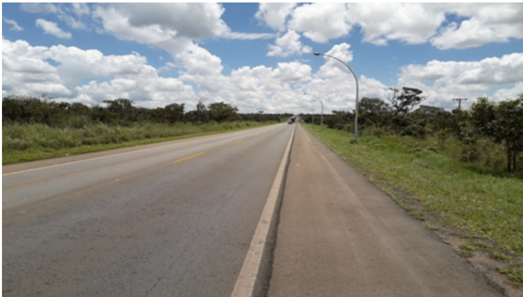
Figura R8 – 08: Trecho da DF-001 ilustrando proximidades do local de implantação da Estrada Real da Bahia construída no período colonial. Sobradinho/DF.
