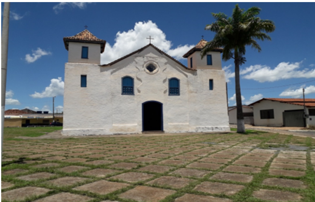
Figura R8 - 04: Igreja do Rosário. Construída no ano 1760. Luziânia/GO.
