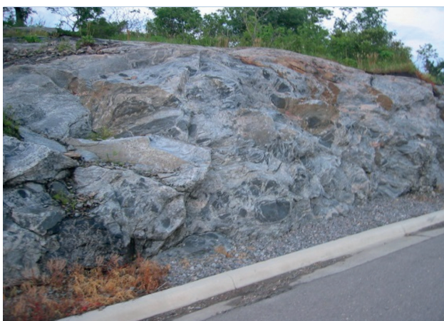
FIG. 03 - Rochas metamórficas aflorantes em rodovia do estado de Minnesota/USA.
