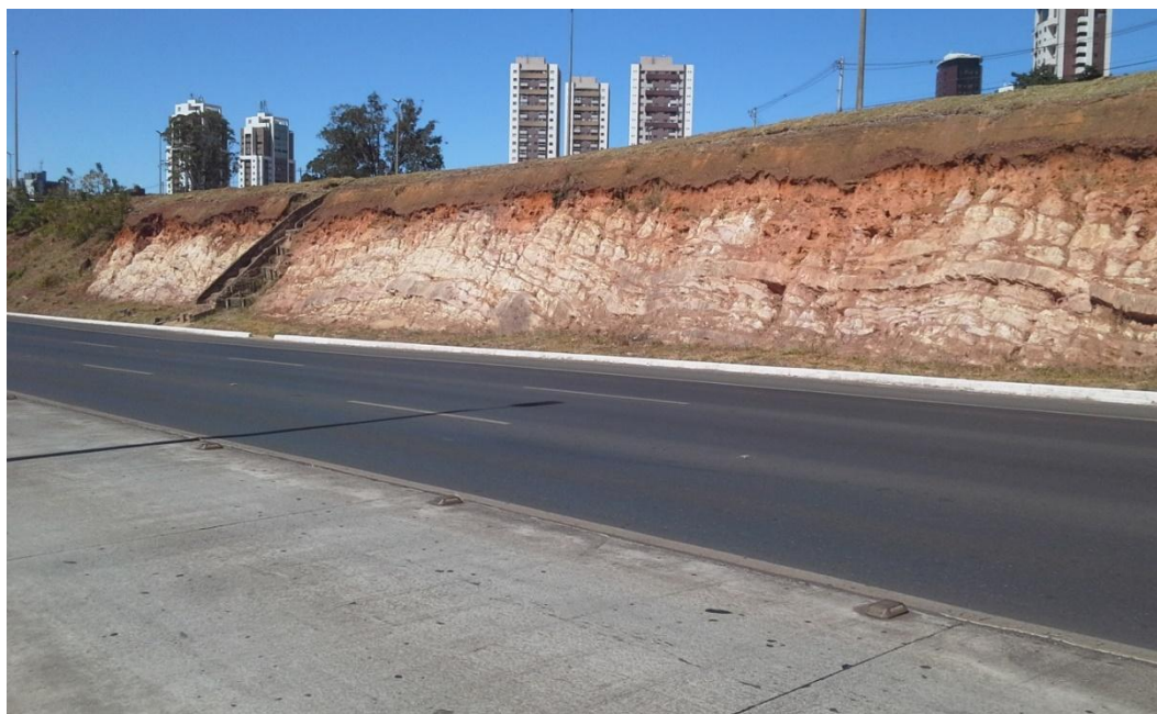
Figura R6 - 01: Corte em via urbana de Brasília (EPTG-Águas Claras) ilustrando rochas quartzíticas e metarritmitos dobrados.
