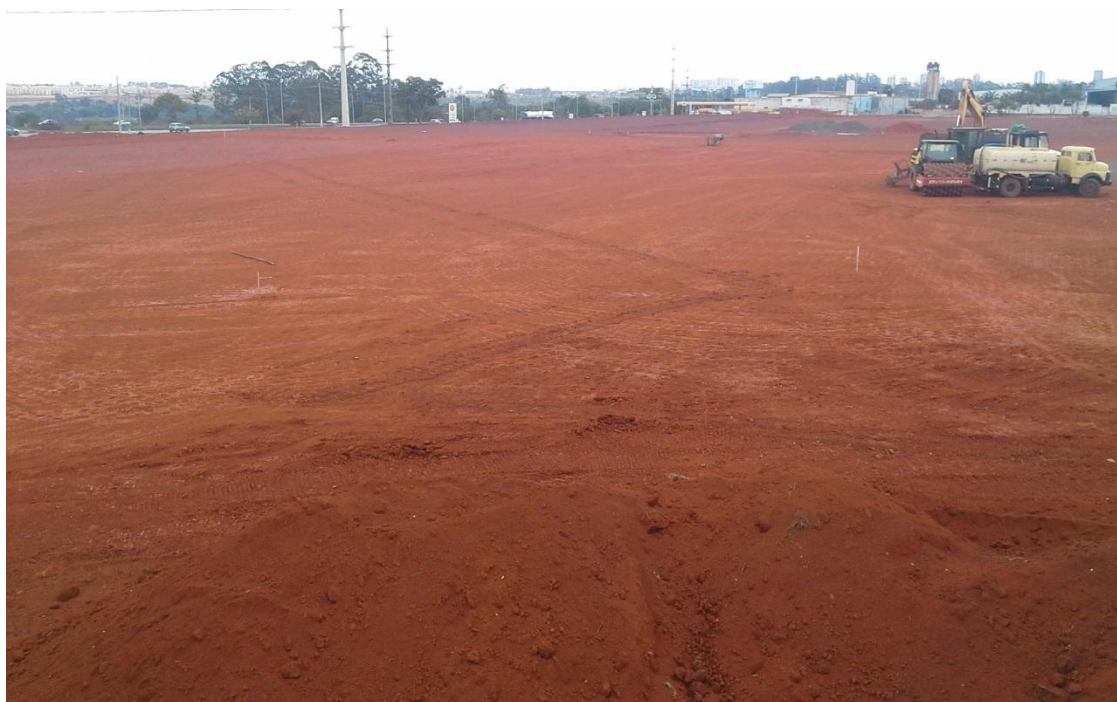
Figura R6 - 02: Horizonte B característico de solos lateríticos exposto pela remoção da cobertura superficial. Trecho próximo a DF-001/EPNB.
