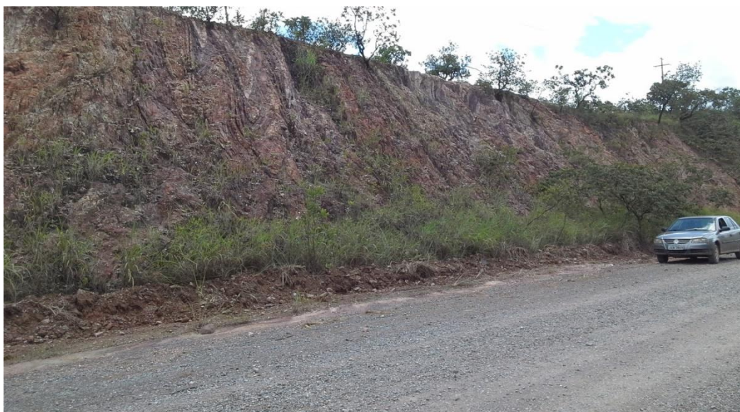
Figura R3 - 16: Corte em trecho da DF-205 expondo filitos e quartzitos dobrados do Grupo Canastra.
