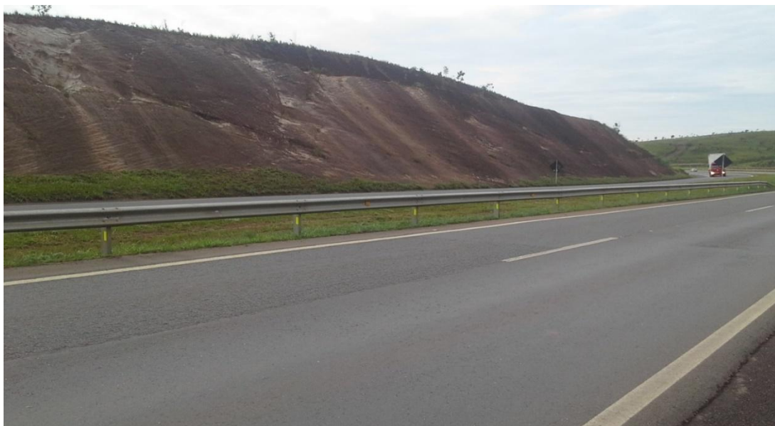
Figura R1 - 04: Corte em trecho da BR-060 próximo a Engenho das Lajes demonstrando filitos e muscovita xistos. Transição do Grupos Araxá/Canastra.
