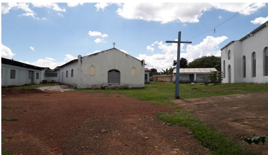
Figura R8 - 07: Capela de Nossa Senhora de Abadia construída no Quilombo Mesquita na década de 1960. Cidade Ocidental/GO.
